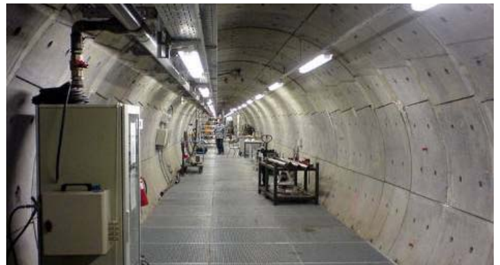
Pogled na najnovejši del podzemnega laboratorija HADES.
